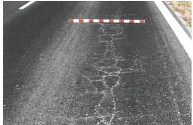
*Fig. I-7 : dégradation structurelle caractéristique de l'usure des couches d'assise qui se traduit par une fissure longitudinale ramifiée (LCPC 1998)*
