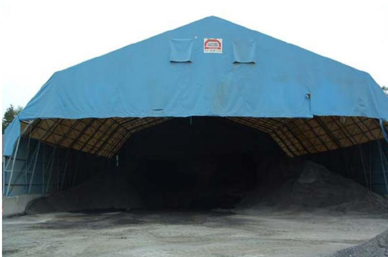
*Fig. I-14 : couverture des lots d'agrégats d'enrobé pour limiter humidité et ensoleillement (Prowell 2007)*
