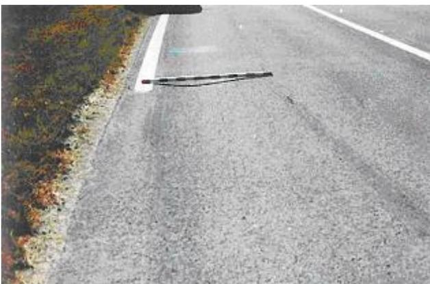
*Fig. I-4 : dégradation superficielle caractéristique d'un ornierage des couches de surface (LCPC 1998)*
