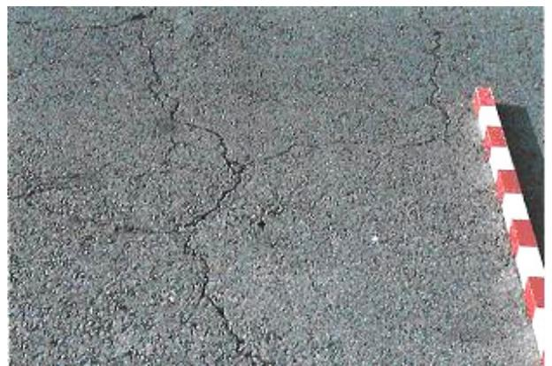
*Fig. I-5 : dégradation superficielle caractéristique de la fissuration par le haut des couches de surface (LCPC 1998)*
