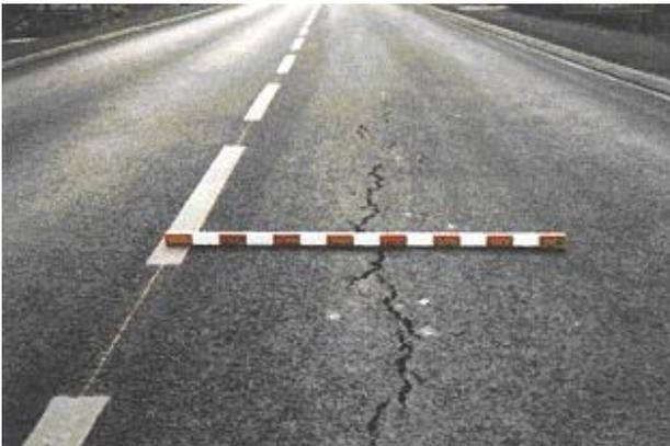
*Fig. I-6 : dégradation structurelle caractéristique de l'usure des couches d'assise qui se traduit par une fissure longitudinale unique (LCPC 1998)*
