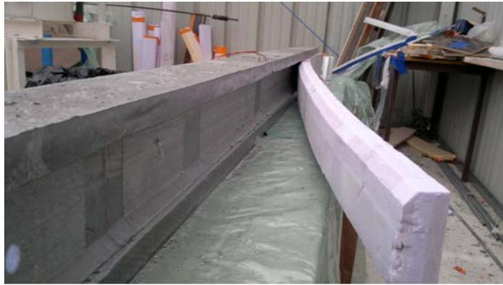
**Fig.3.21 Démoulage des poutres**
