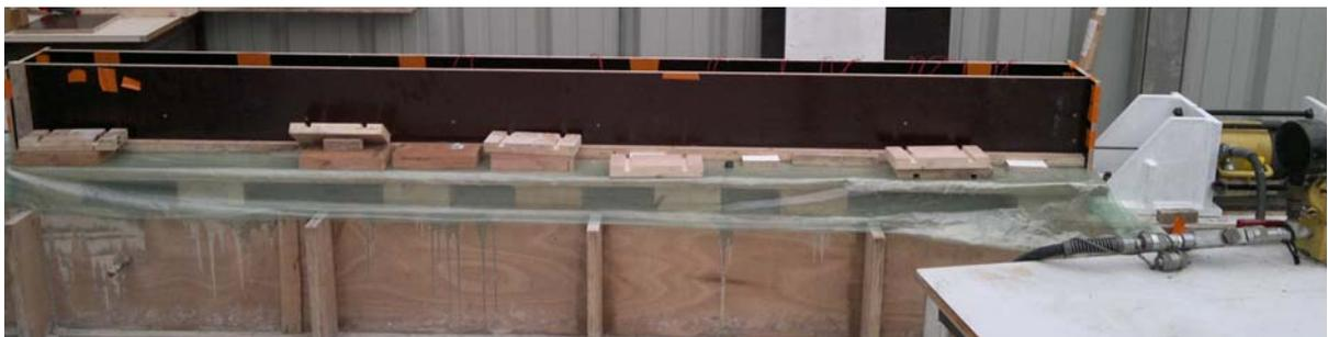
**Fig.3.19 Coffrage des poutres précontraintes fixé sur le lit de précontrainte**
