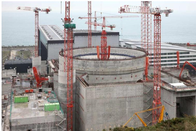
FIGURE 1.4 – Enceinte de confinement de l'EPR en construction sur le site de Flamanville.
