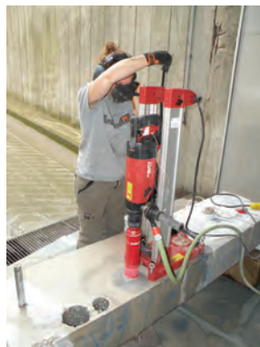
Figure 4-64 : extraction d'une carotte de 60 mm de la poutre P2
