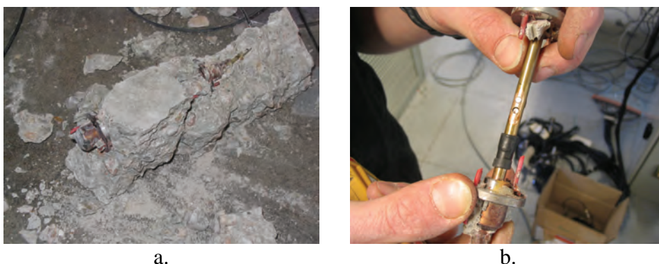
Figure 2-54 : diagnostic du problème des capteurs à corde vibrante après cure thermique (a. récupération du capteur ; b. déplacement d'un aimant)
