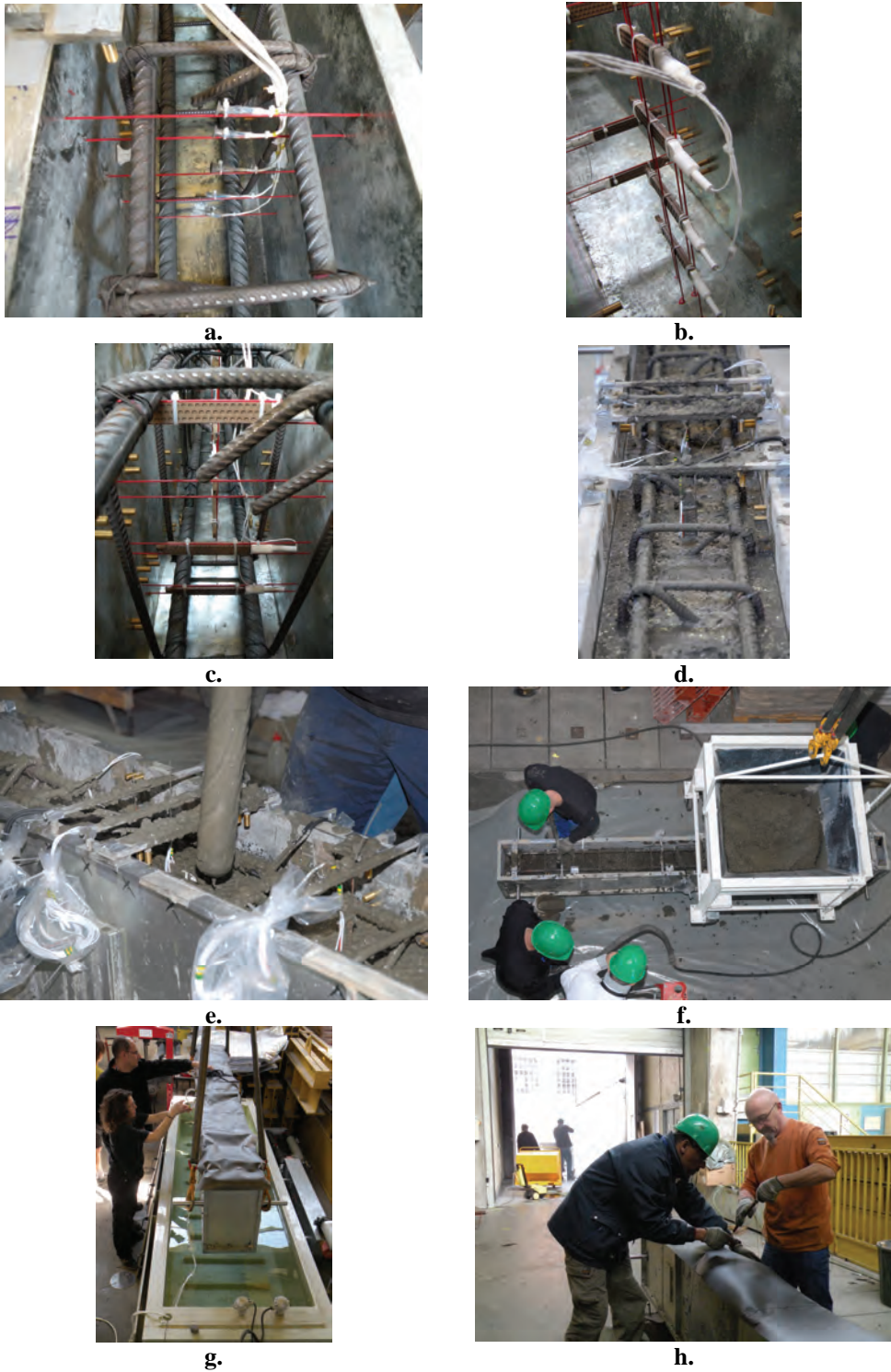
Figure 2-64 : fabrication de poutres
