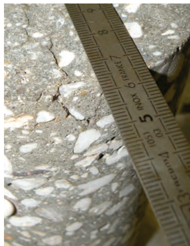
Figure 3-3 : fissuration d'une échantillon de gonflement libre R1 après 450 jours de conservation en eau
