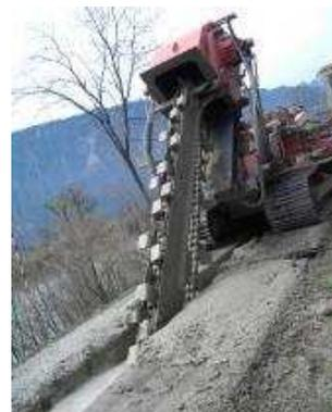
FIGURE 1.4 – Mise en œuvre de tranchées traitées en place par trancheuse (*sources : [Jeanty et al., 2013] et site internet Stucky*).
