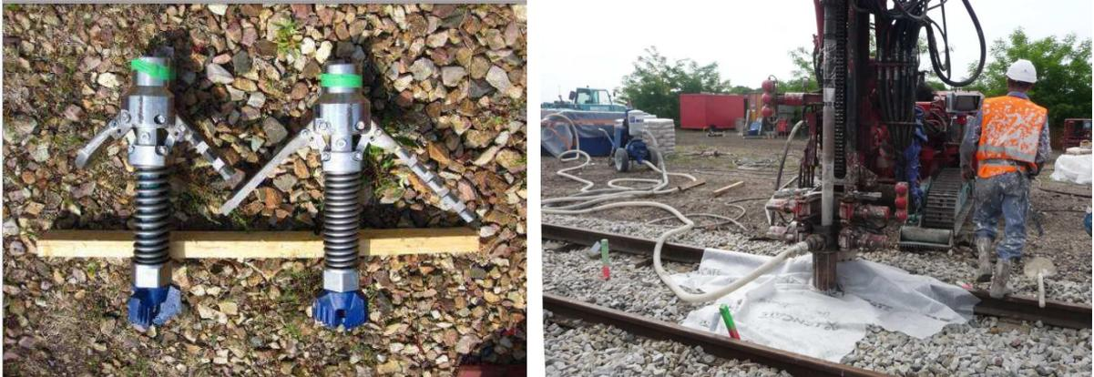
*Figure I-52 – Outils et machine d'exécution des colonnes en «soil-mix» réalisé en dessous d'une voie ferrée*
