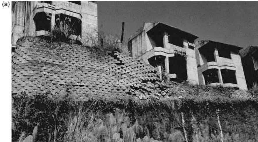
*Figure 1-24 : Rupture d'un remblai renforcé par des géotextiles lors du séisme Ji-Ji [LIN01a]*
