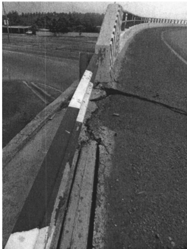
*Figure 1-25 : Fissures provoquées par le déplacement horizontal d'un remblai en Terre Armée au cours d'un séisme [WAR06]*
