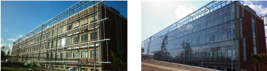
Figure 1.11. Construction d'une façade double peau vitrée dans le campus de l'Université de Bordeaux, sans vitrages (à gauche) et avec vitrages (à droite).
