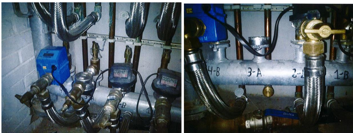
Photos 23 et 24 : La fraude et sa résolution. A gauche, un branchement illégal sans compteur (3A), à droite, la bride en fonte soudée pour empêcher toute tentative de récidive
