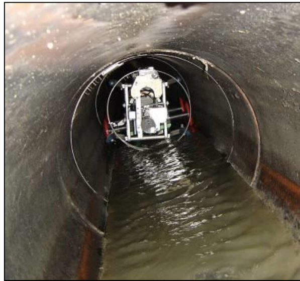
Photo 34 : Le réseau d'assainissement et, au fond, les câbles de fibre optique à insérer
