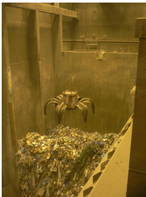
Photo 40 : L'incinérateur vu de l'intérieur – plongée dans la Metropolis du déchet
