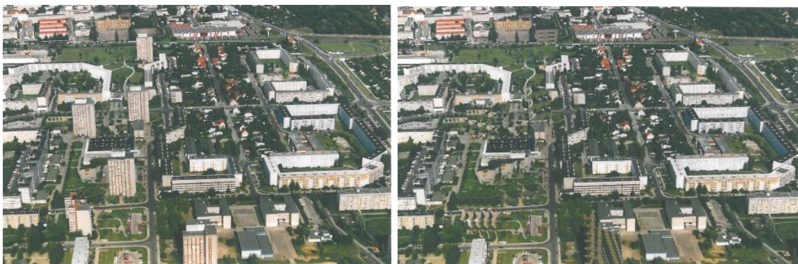
Photos 27 et 28 : Démolitions de grandes tours dans Neustädter Feld
