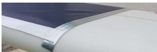
Figure 59 : Bande d'étanchéité bitumineuse
