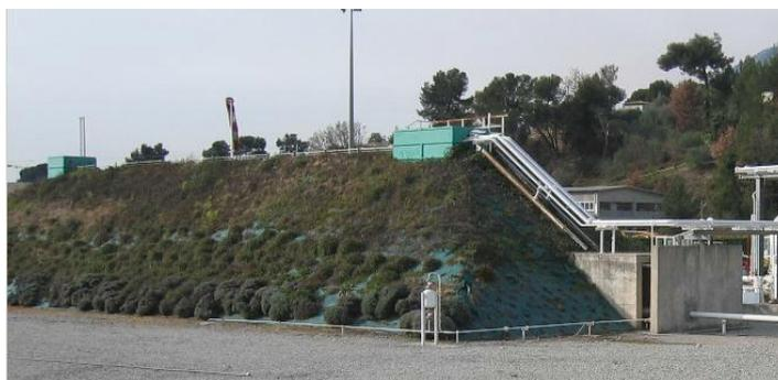
**Figure 3-2 Réservoir sous talus de propane**
