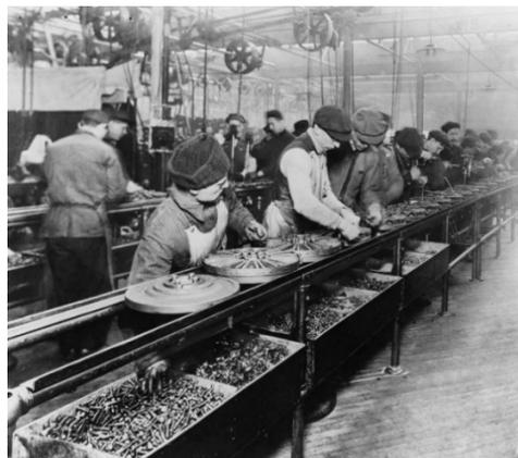
Figure 1 : Ligne d'assemblage Ford du magnéto de démarrage (1913). Une fragmentation des tâches léguée du système taylorien et une standardisation du système de production introduite par Ford (McKenzie, 2015).
