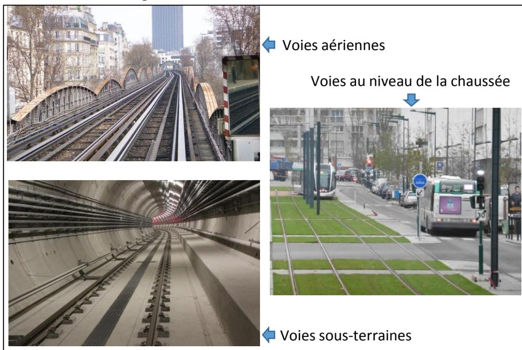
Figure II.7 : Illustration des implantations possibles de voies ferrées
