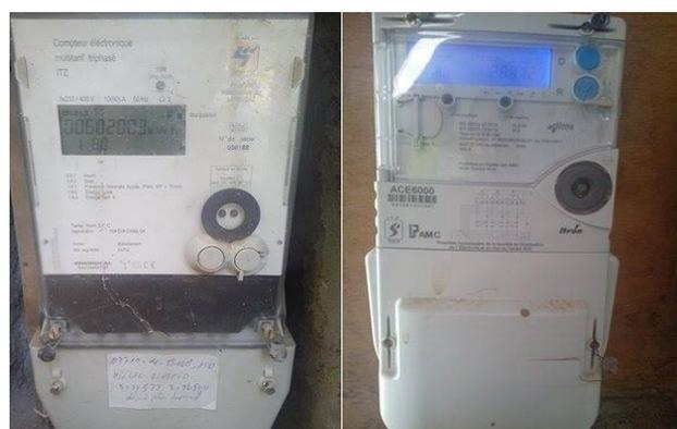
*Photos 10. Deux modèles de compteurs de la consommation électrique*
