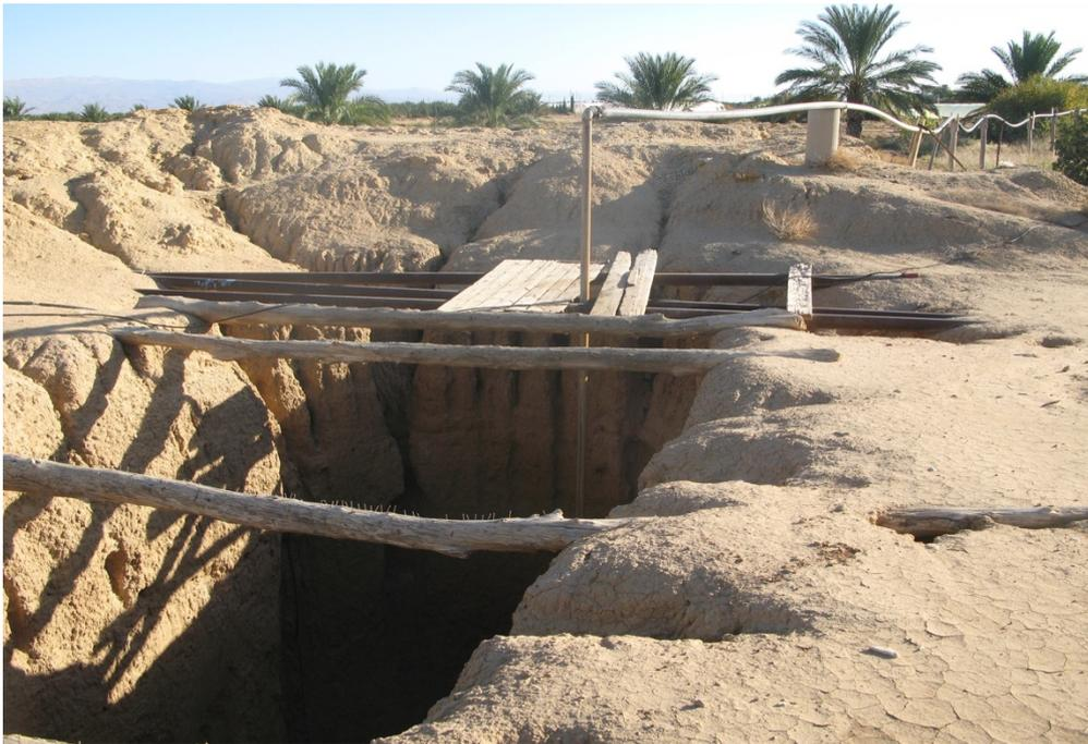
*Photo 13. Forage creusé au milieu d'un puits (extension Tadjdid)*
