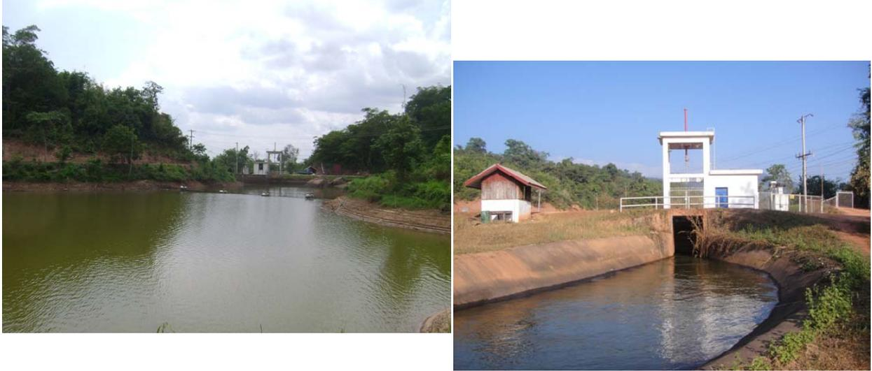
Photo 79 : Vanne entre le bassin de régulation et le canal d'irrigation en béton
