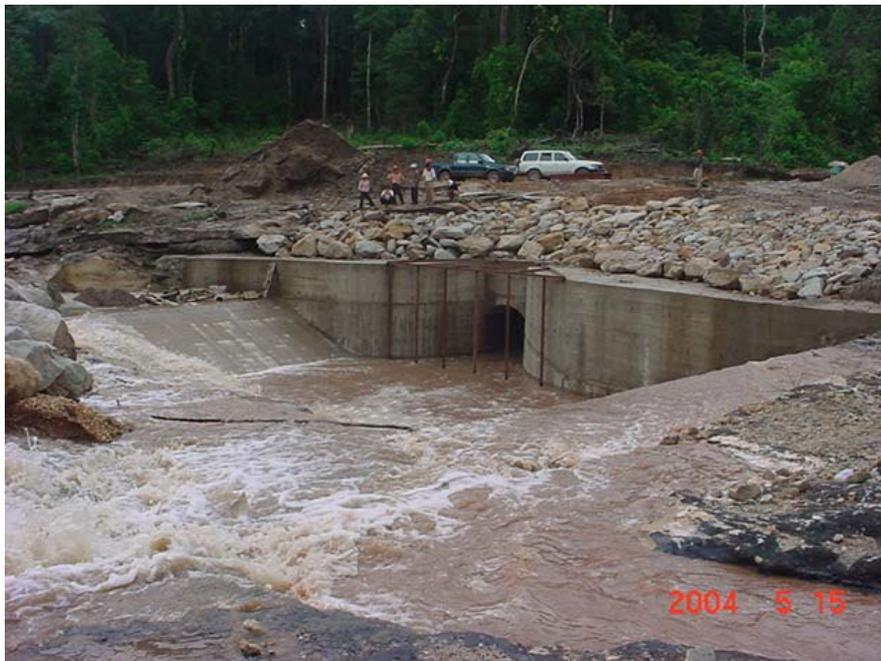
Photo 76 : Digue pour dériver l'eau du Houay Khouang au réservoir de Nam Mang 3
