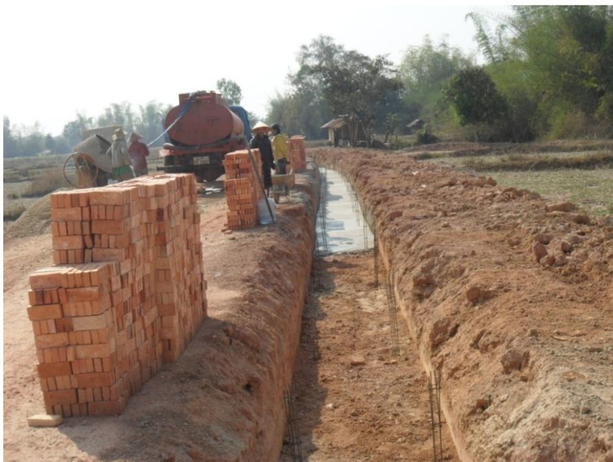
Photo 44 : La construction du réseau de canaux d'irrigation en béton
