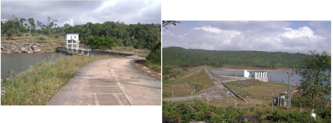
Photo 75 : Digue en terre compressée (ou barrage secondaire) d'une hauteur de 19 m
