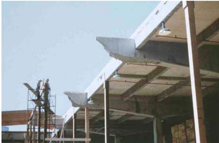
FIGURE 1.1 – Rupture des poutres de l'entrepôt AMC du Wilkins Air Force (États-Unis, 1955) (Collins *et al.*, 2008)
