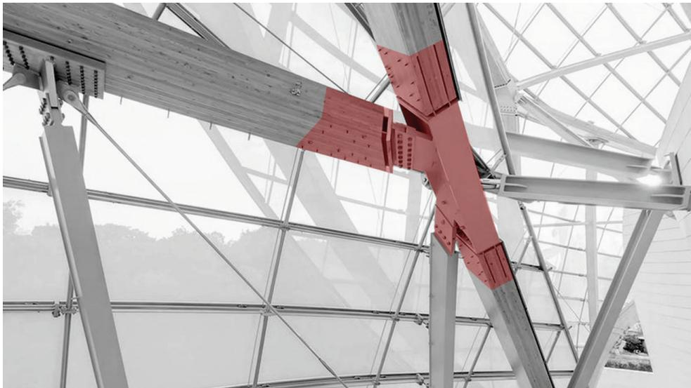
**Figure I-4** Deux visions des structures en bois : système d'éléments ou système d'assemblages.
