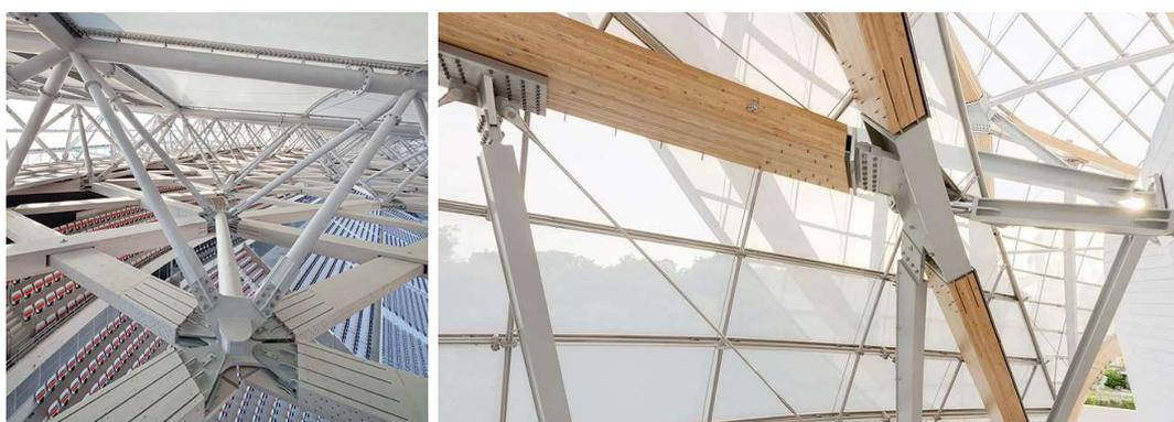
**Figure 1-1** Assemblages par broches du stade de l'Allianz Riviera à Nice construit en 2013 et de la Fondation Louis Vuitton à Paris construit en 2014
