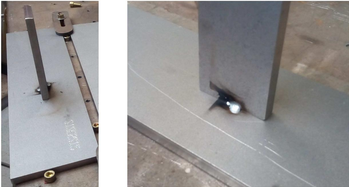
FIGURE II.16: Position des points de soudure sur les structures gousset. Un point de soudure est réalisé de chaque côté de l'âme au milieu de la trajectoire de soudage longitudinale.
