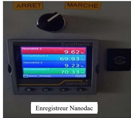
Figure 50- Enregistreur Nanodac permettant de contrôler la température et l'humidité
